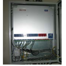
Belirlenen noktaları izleyen SKF sensörleri ve SKF IMx online takip sistemi
